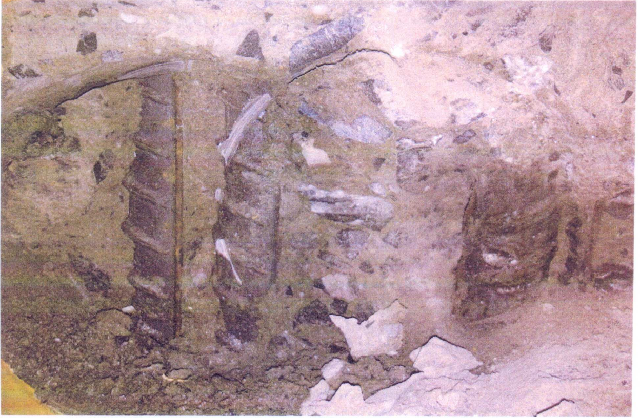
Resim 9. Taşıyıcı elemandaki beton ve donatı görünüşü
