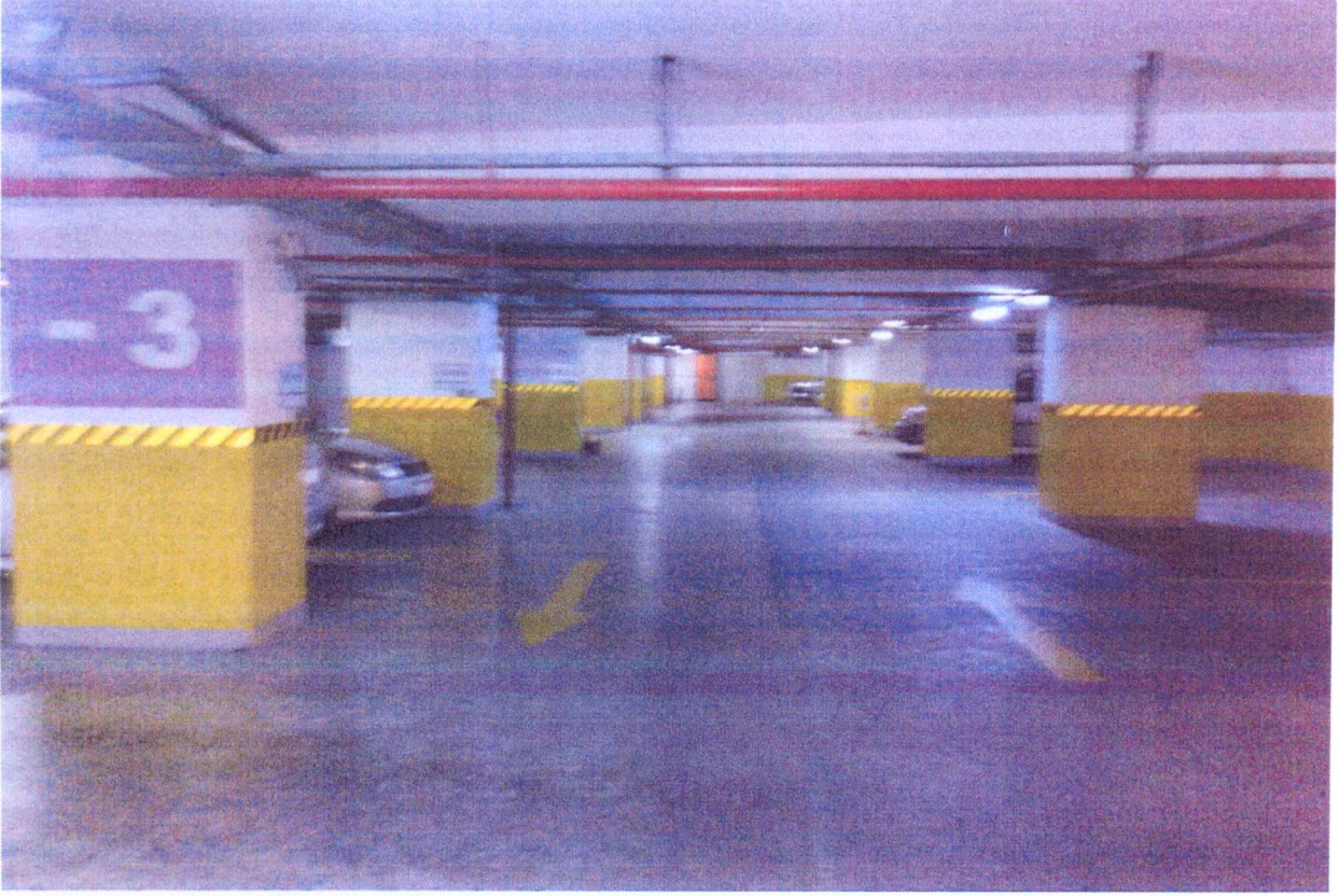
Resim 7. Otopark katından görünüş
