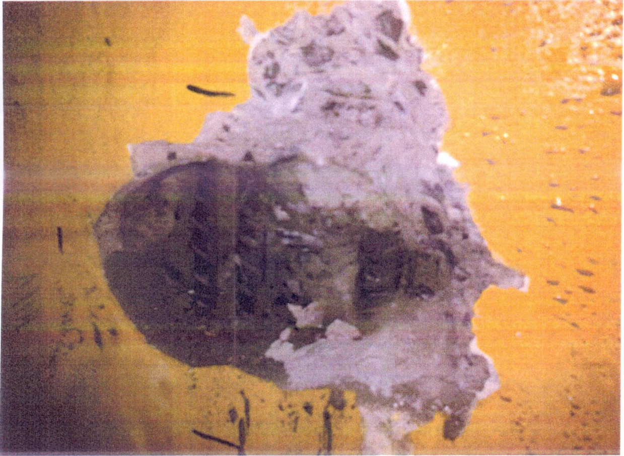
Resim 12. Karot alınan bölgenin ve donatılarının görünüşü
