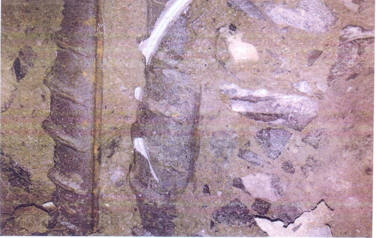
Resim 5. Taşıyıcı elemandaki beton ve donatı görünüşü
